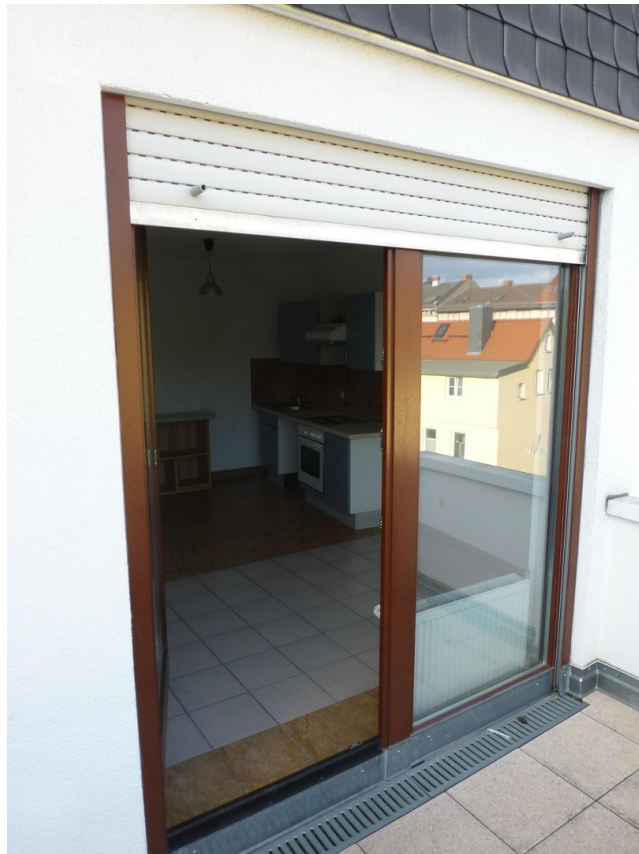
Blick vom Balkon zur Balkontür
