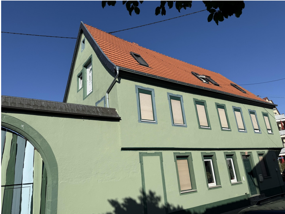
Frontansicht der Ostseite
