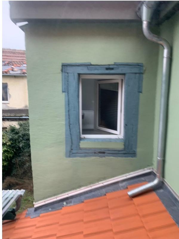
Fenster ins Bad
