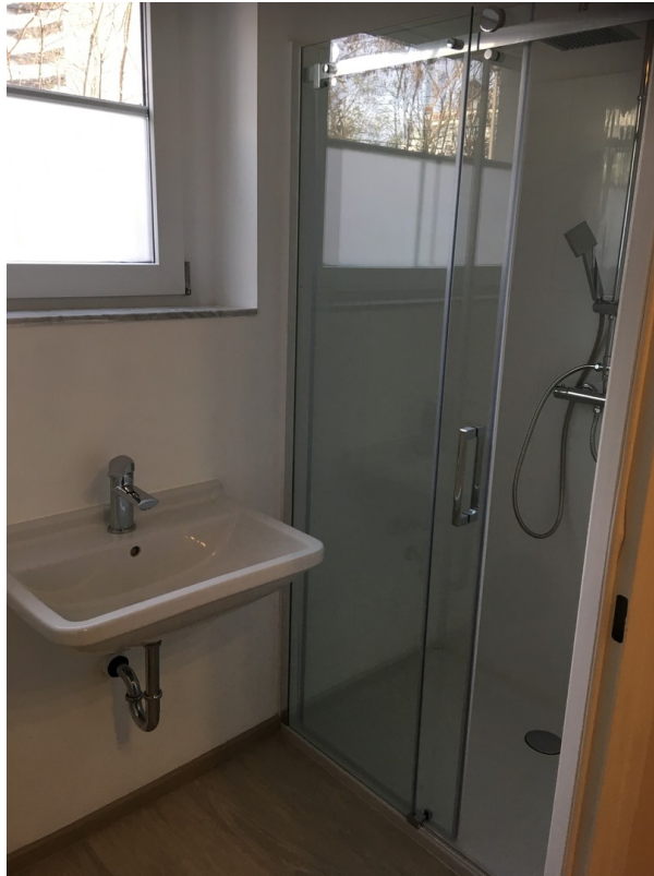
Dusche und WC Raum 2
