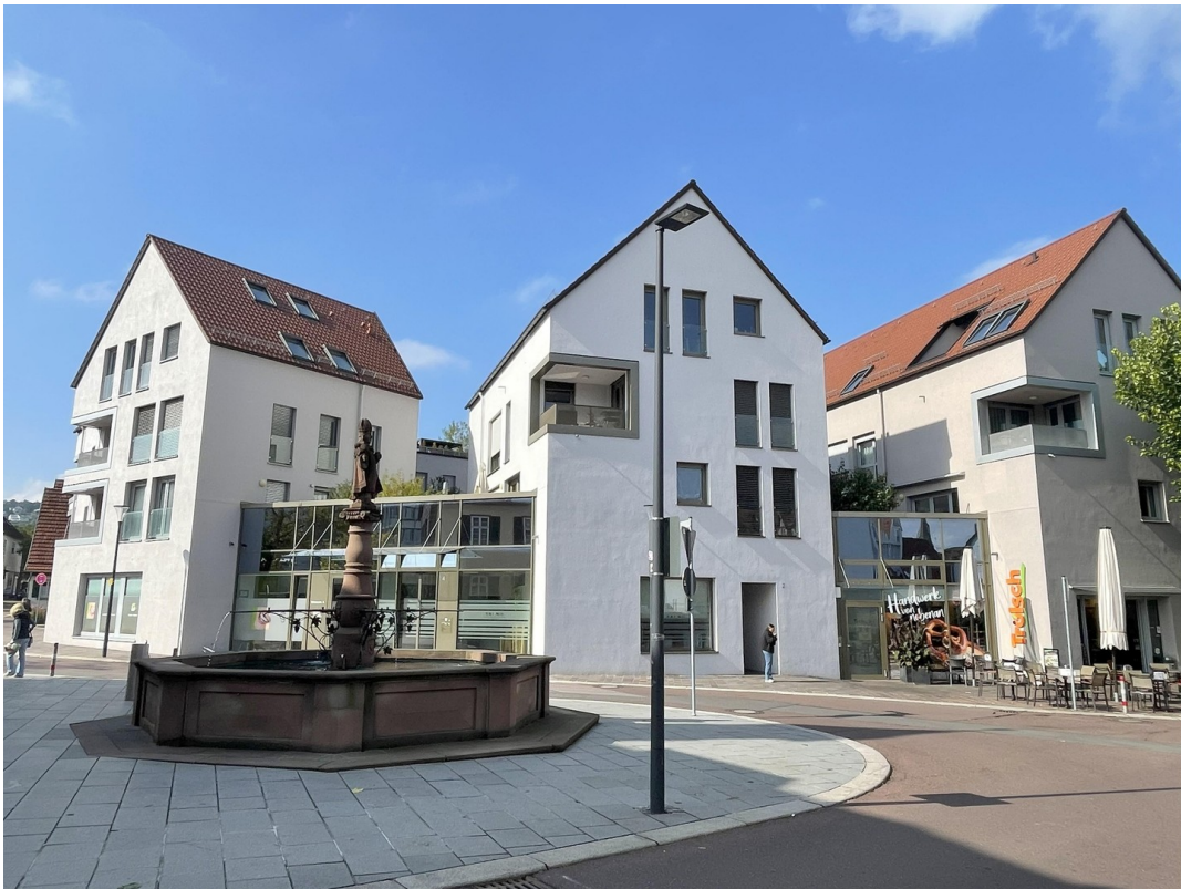
Gebäudeansicht von Ost
