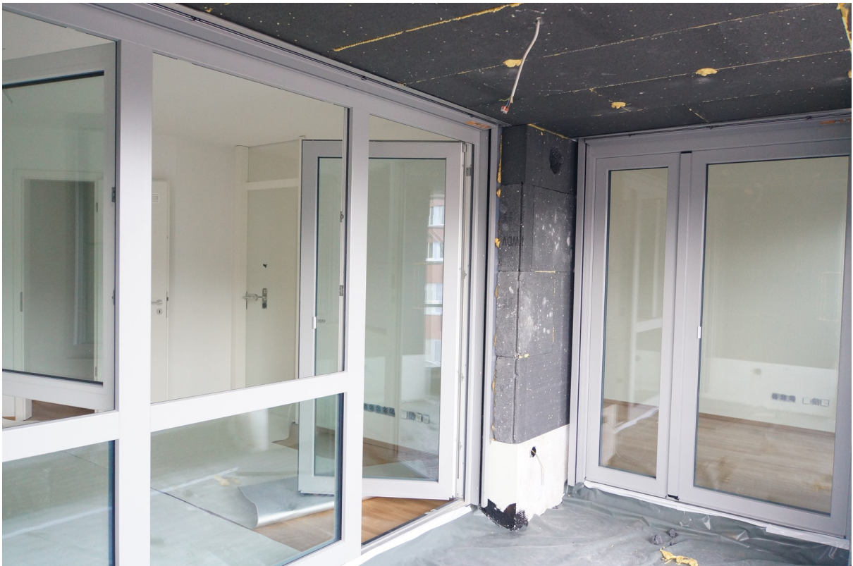
Balkon - Blick zur Wohnung
