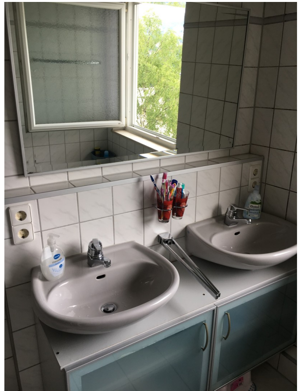
Bad mit Waschbecken&Unterschr.
