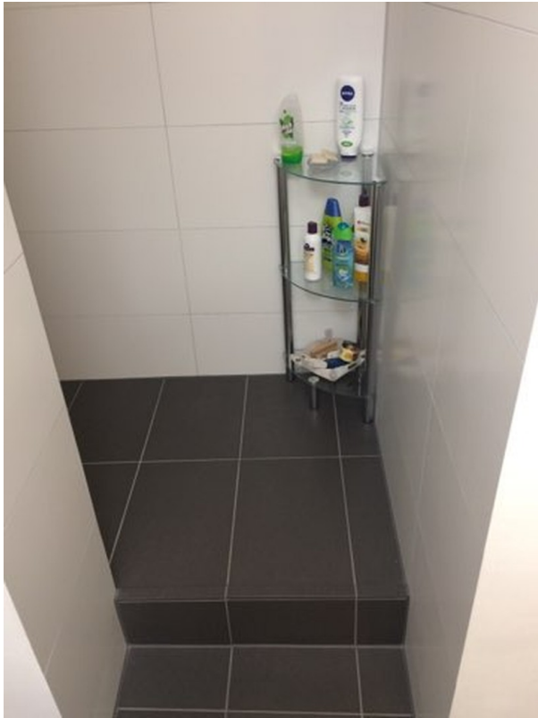
Eingang zur Dusche
