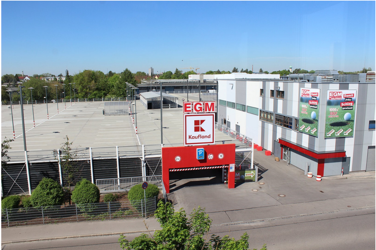
Blick auf Parkgebäude
