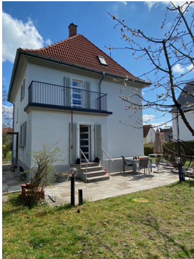
Westbalkon nach Sanierung 2020
