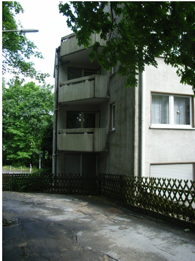
Außenansicht Süd West
