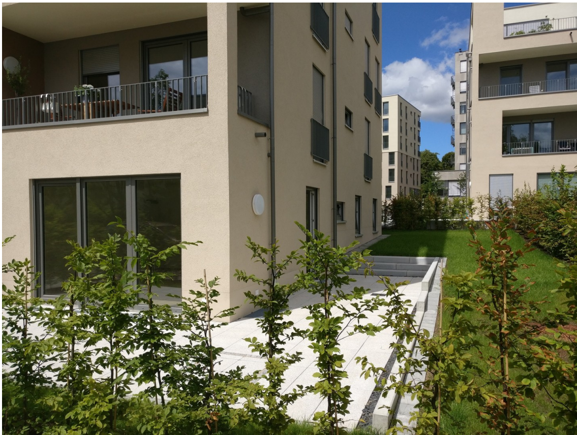
Hecke als Sichtschutz
