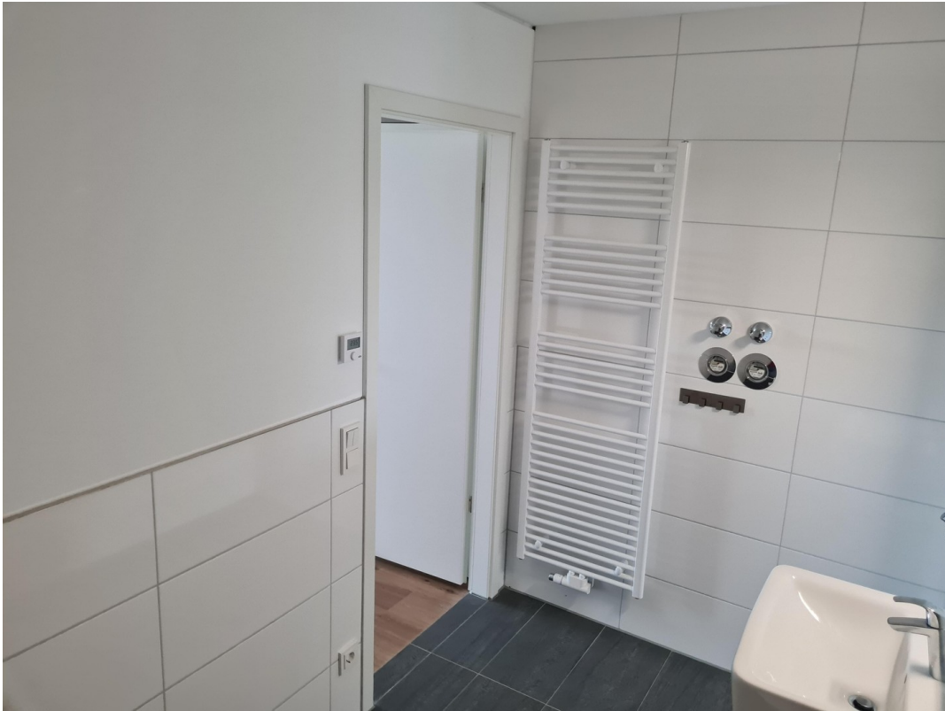
Wannenbad mit Handtuchheizkörper
