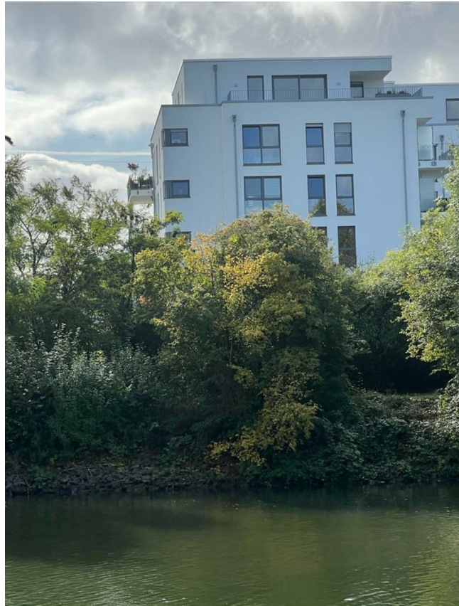
Hausansicht vom Kanal
