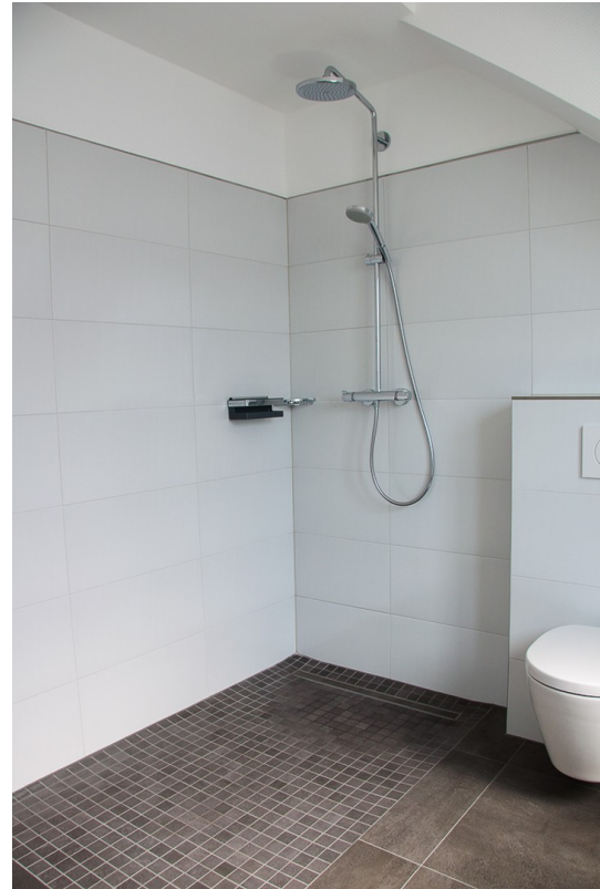
Bad (bodengleiche Dusche)
