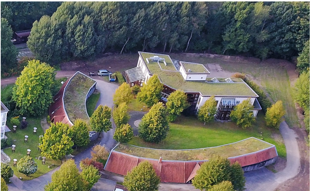
Haus "H" und Hufeisengebäude
